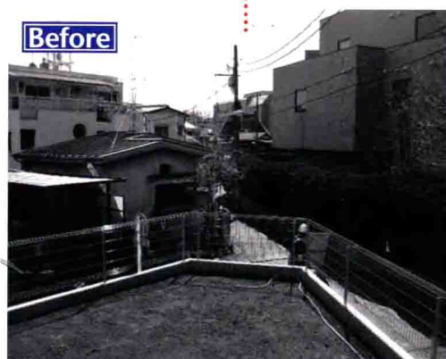
① 施工前的庭院全景。
