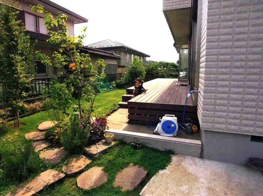
铁质木材建造的木连廊。护墙板只使用了混凝土，然后做了硅质材料的防水。
