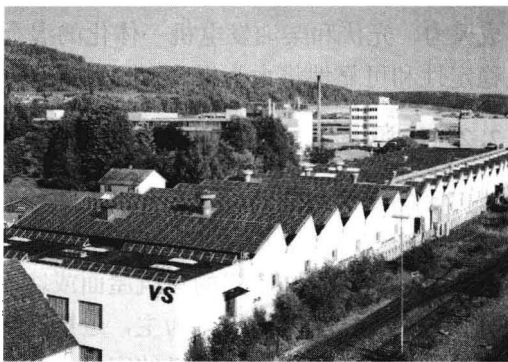
图 1-5 德国某家具厂屋顶发电系统
