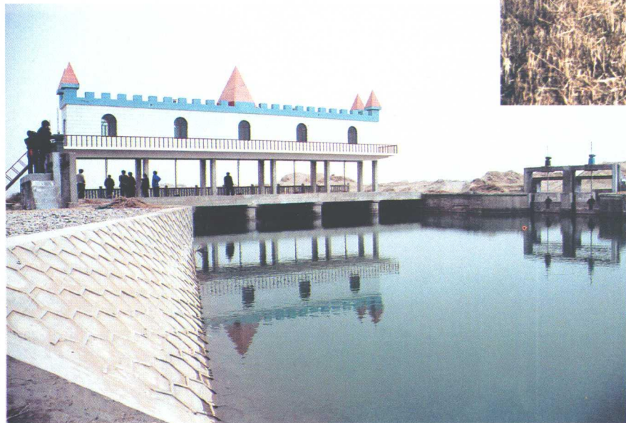
塔北二干渠输水工程中段节制闸（1998年）
