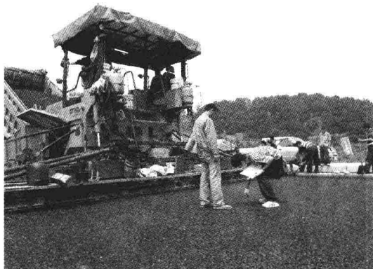
图 1-6 沥青混凝土面层试验路段施工——现场厚度检测
