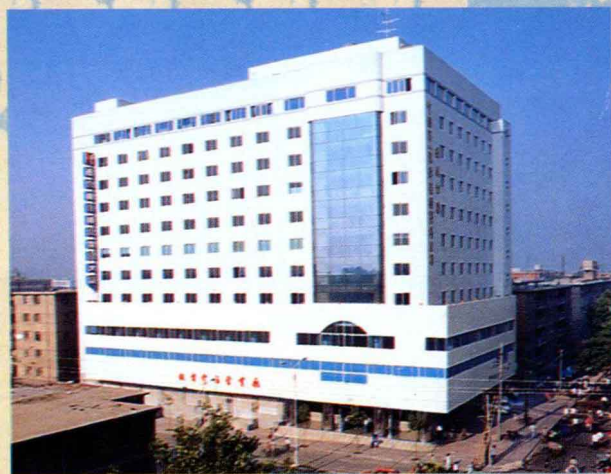
西安南非 祥发集团大厦外 景
