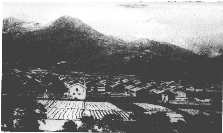
翠亨村南面旧貌
