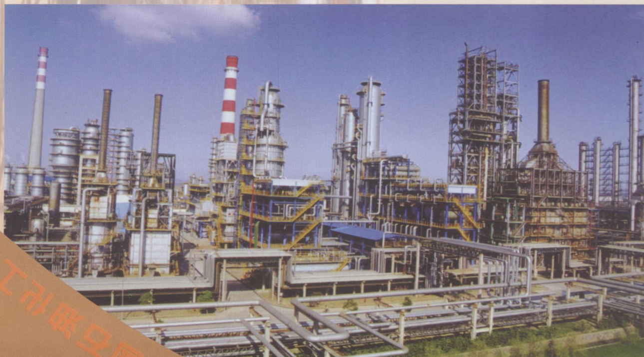
镇海炼化800万吨/年炼油工程
