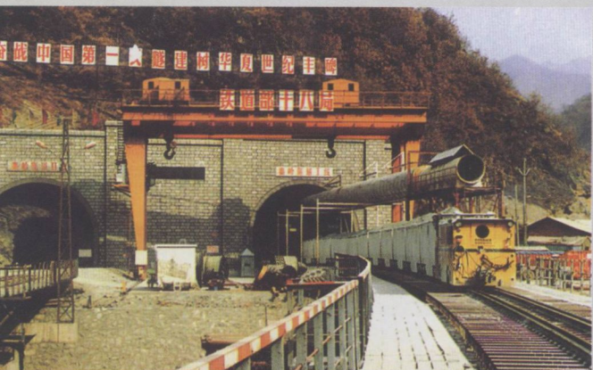
● 目前国内最长的西康铁路秦岭隧道使用TBM掘进机施工
