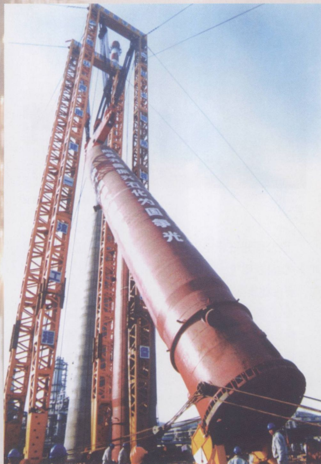
齐鲁炼油改扩建工程中吊装重量达1033.5吨的精制反应器一次整体吊装就位
