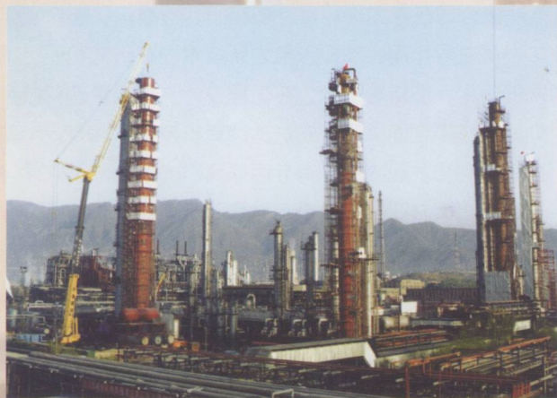
燕化66万吨/年乙烯改扩建工程
