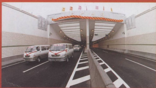
中国第一条内资BOT四车道沉管隧道（宁波常洪隧道）
