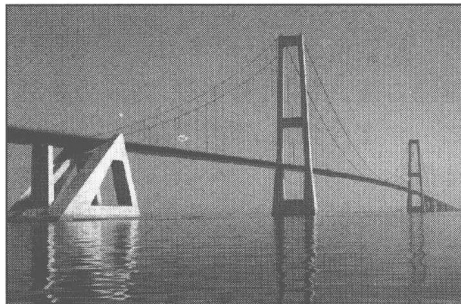
图 1-2 大贝尔特东桥三角形空腹构架重力锚
