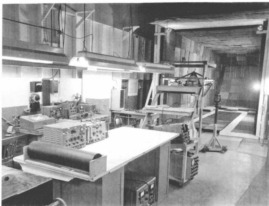
这张罕见的照片大约拍摄于1957年，图中是82号楼内洛克希德公司“臭鼬工厂”的所在地。在房间的深处是世界上第一间消音室。随后，鞋子大小的中情局侦察机模型将被悬挂在天花板上进行测试。（洛克希德·马丁公司提供）
