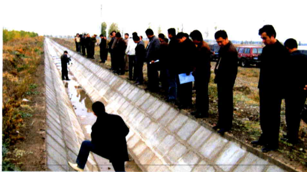
新农村水利设施建设
