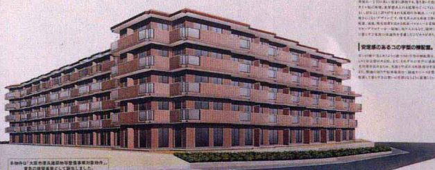
本館の外観は、落ち着いた色調のタイル貼で、重厚感あふれる佇まいです。
