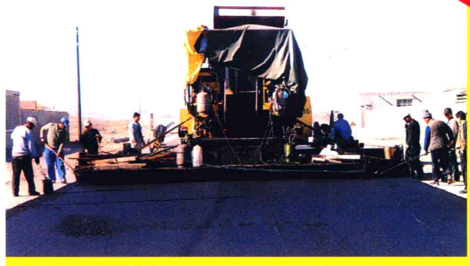
◀ 重点农村公路摊铺施工现场
