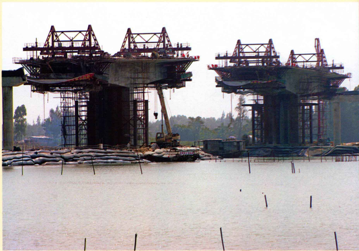
建设中的南三大桥 黄观弟摄
