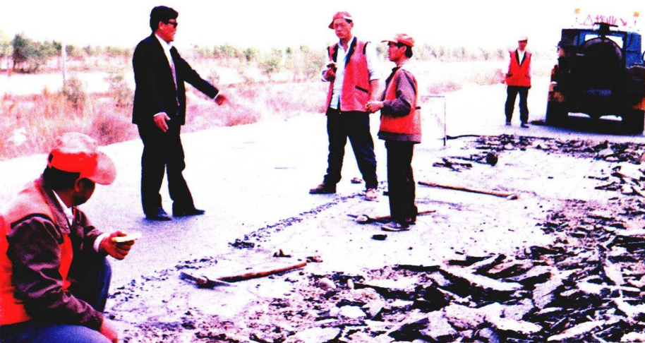
公路工程小修队 对路面小修保养
