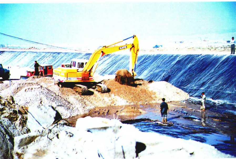
沙井子引水渠防 渗工程施工工地 (1998年)
