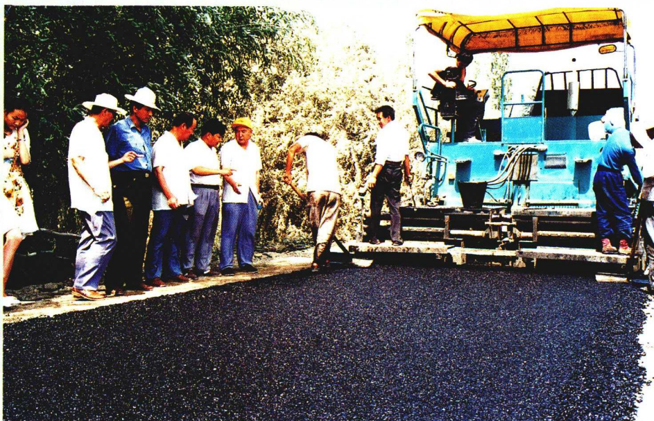
LTL45 型沥青 混凝土摊铺机现场 作业
