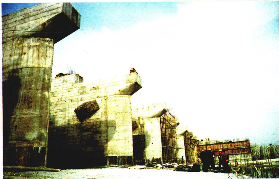
协合拉引水闸枢 纽工程施工现场 (1997年)
