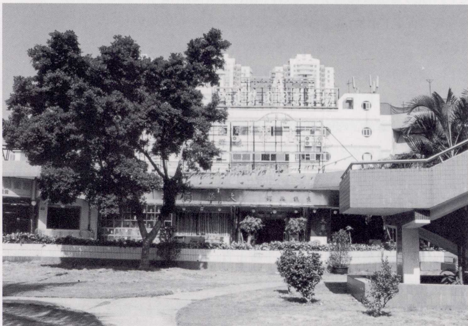
改造前的园岭，《深圳人的一天》原址 1999年11月20日
