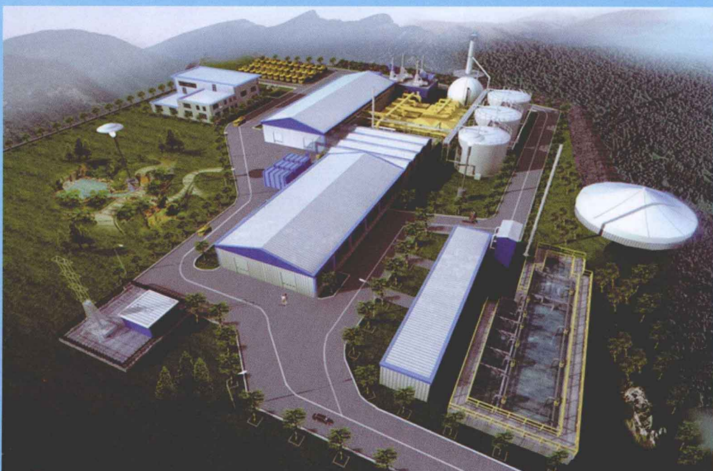
兰州市餐厨废弃物无害化处理资源化利用项目正式投产。该项目总投资1.13亿元，日处理餐厨垃圾200吨，可最大限度地“吃干榨尽”餐厨垃圾，全部转化为清洁电力、生物柴油、有机肥等能源资源产品
