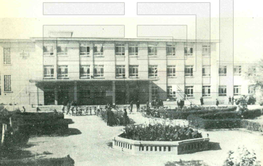
州人民医院住院大楼
