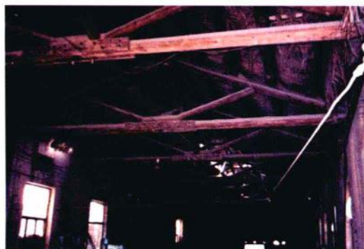
建团初期电杆车间工房
