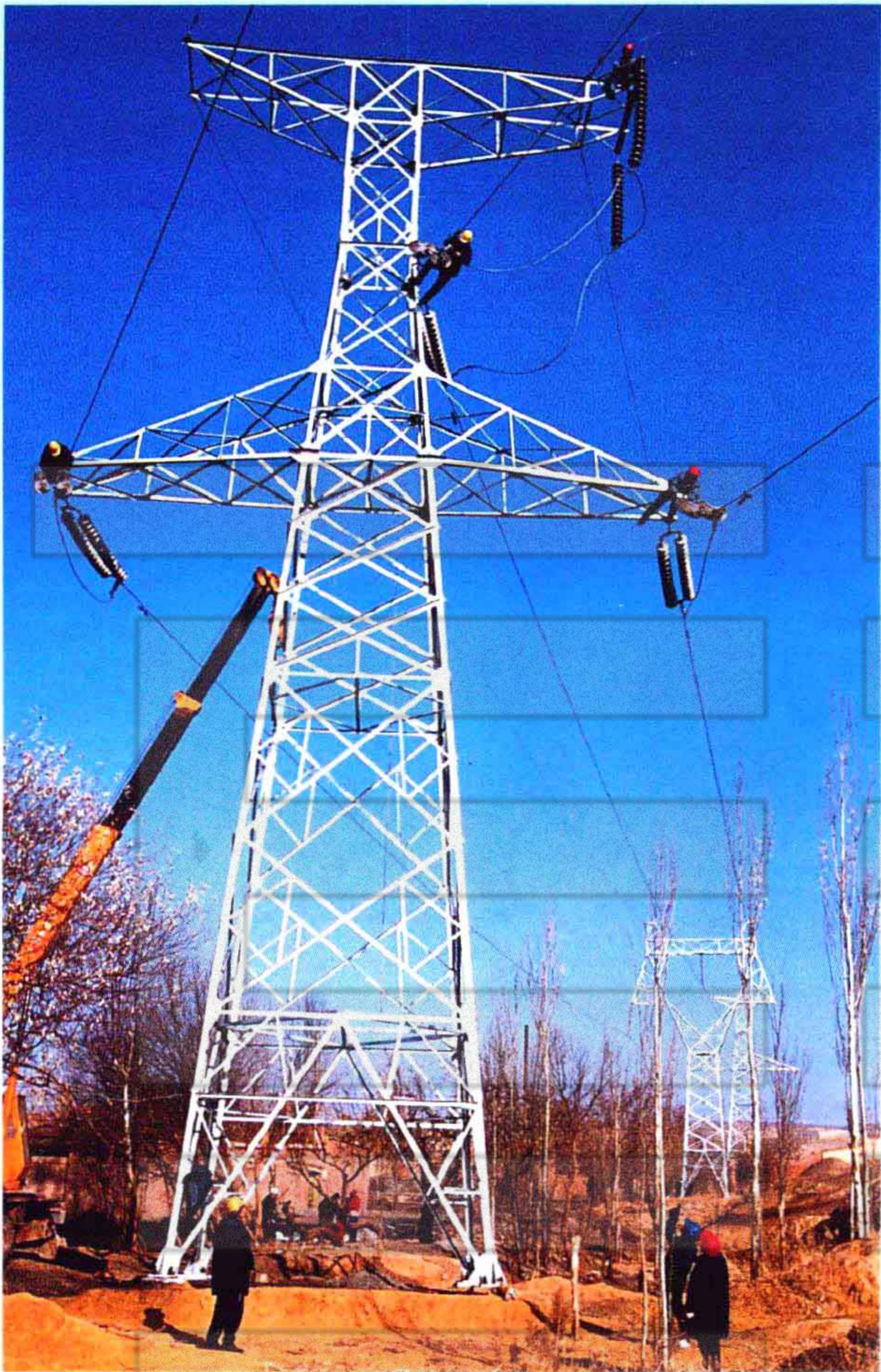
施工中的 220 千伏线路
