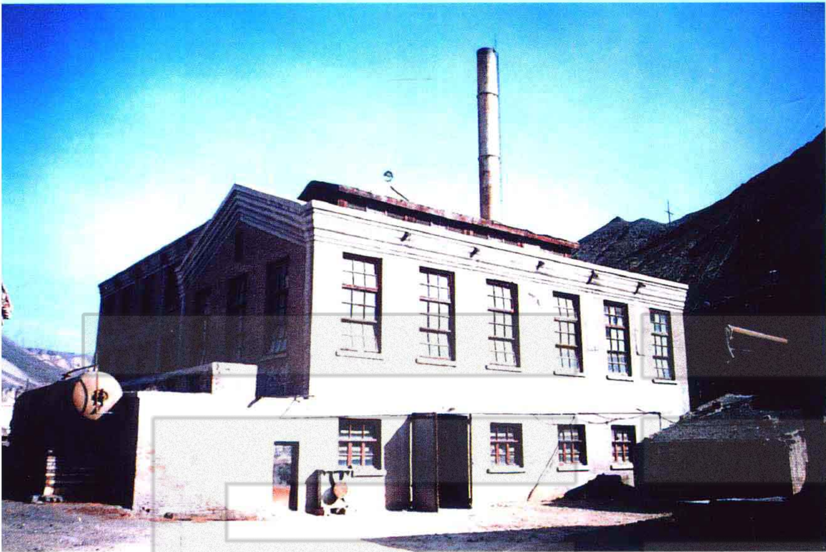
红星煤矿电厂主厂房
