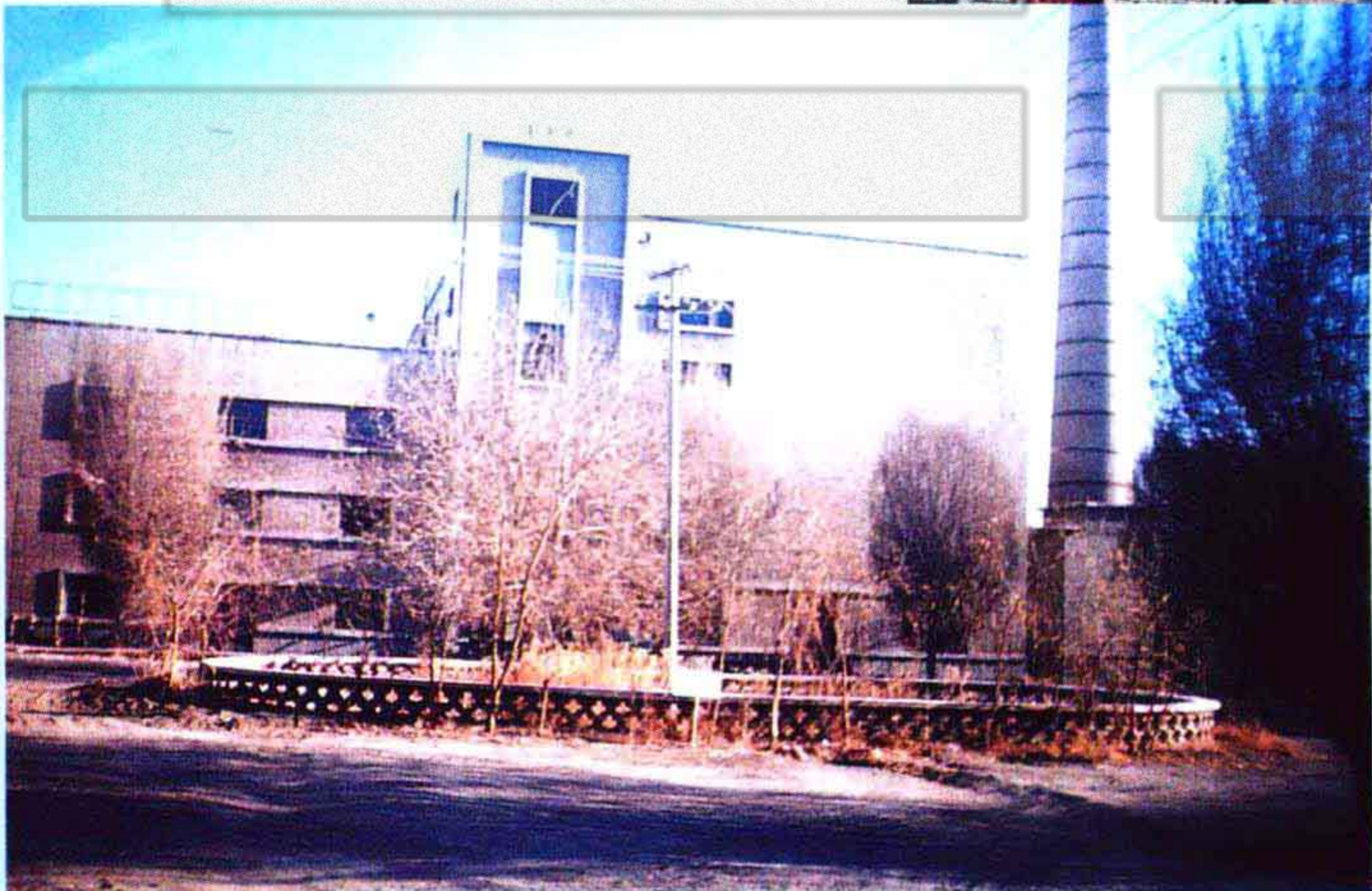
鄯善县火电厂外貌
