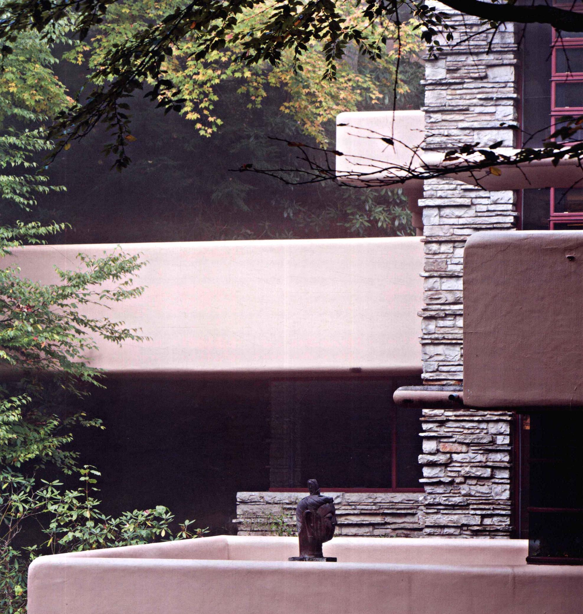
折起的钢筋混凝土阳台，构成别墅主楼的楼层。阳台交错组合，之间的隔断只是长型的横窗。每一层楼都几乎一半悬空，构成依次排列的方台，其支撑部分便是石砌的塔楼。水平悬臂式楼层从塔楼中延伸出来并一直向西、向南延伸，悬挂在溪水之上。
