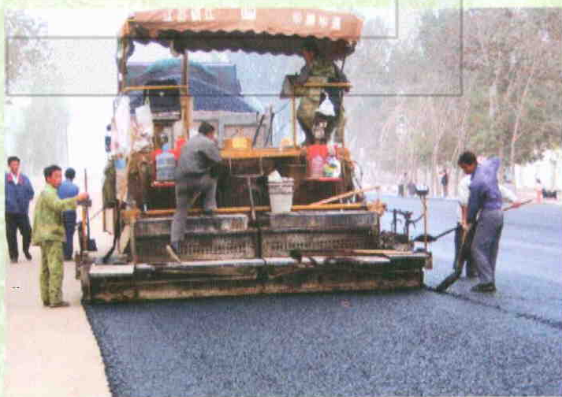
▲ 修建通连公路
