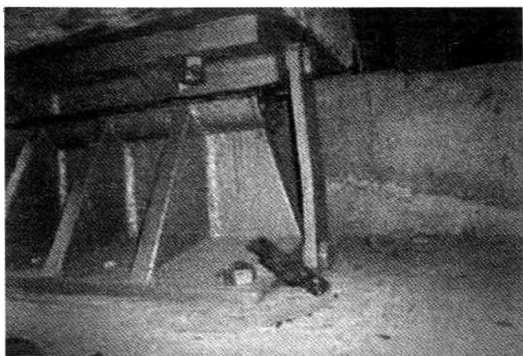
图 1-3 铰轴支座在铰轴处发生横向错位
