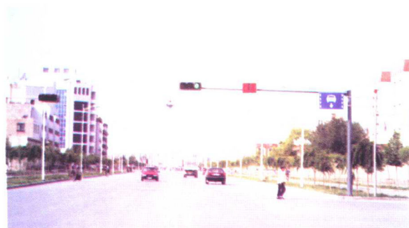
城市道路建设(上)
