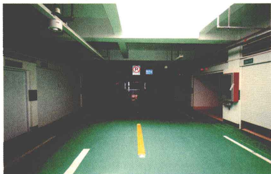
图9 地下室自然采光通风
