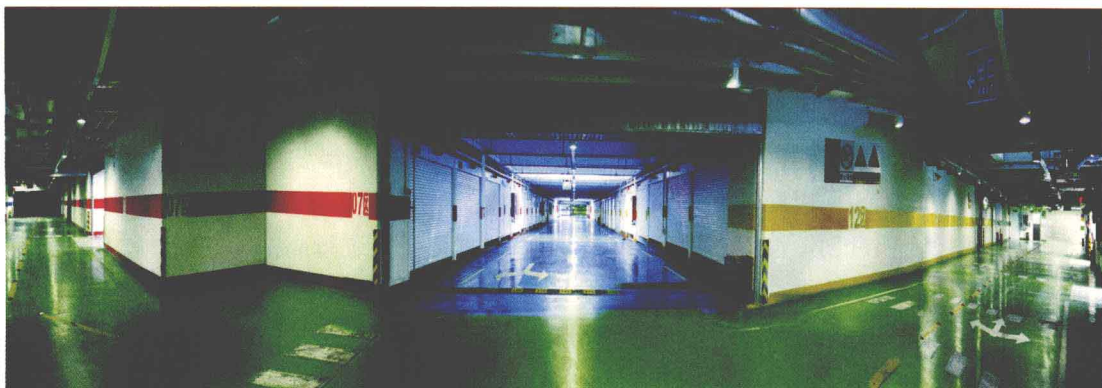
图8 通透明亮的地下车库
