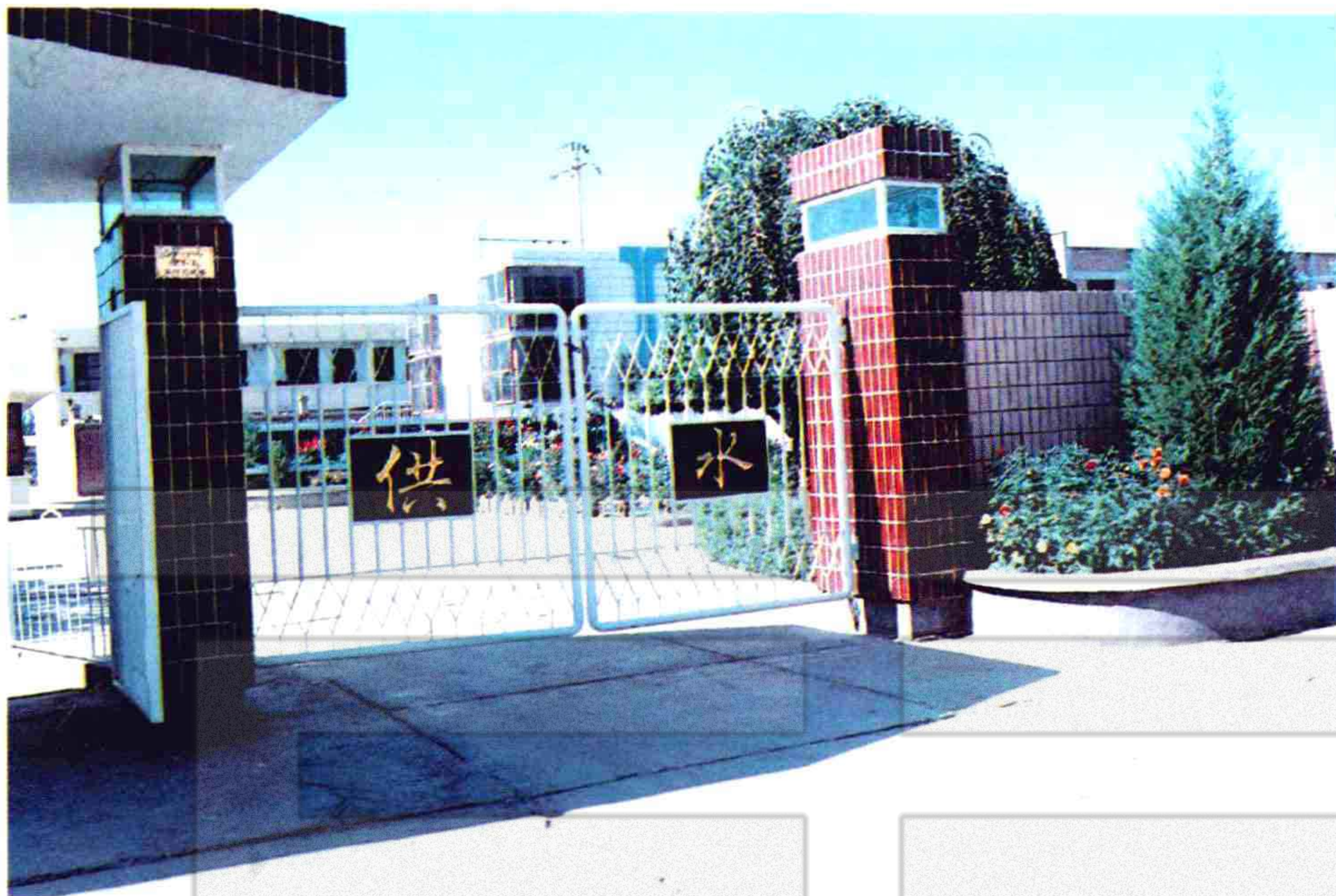
阿克苏市供排水公司新城加压泵站
