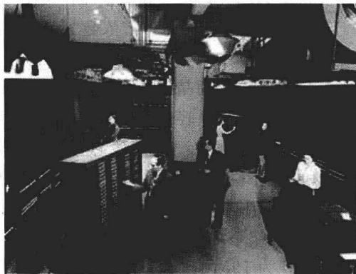
图1-1 世界上第1台数字式电子计算机——ENIAC
