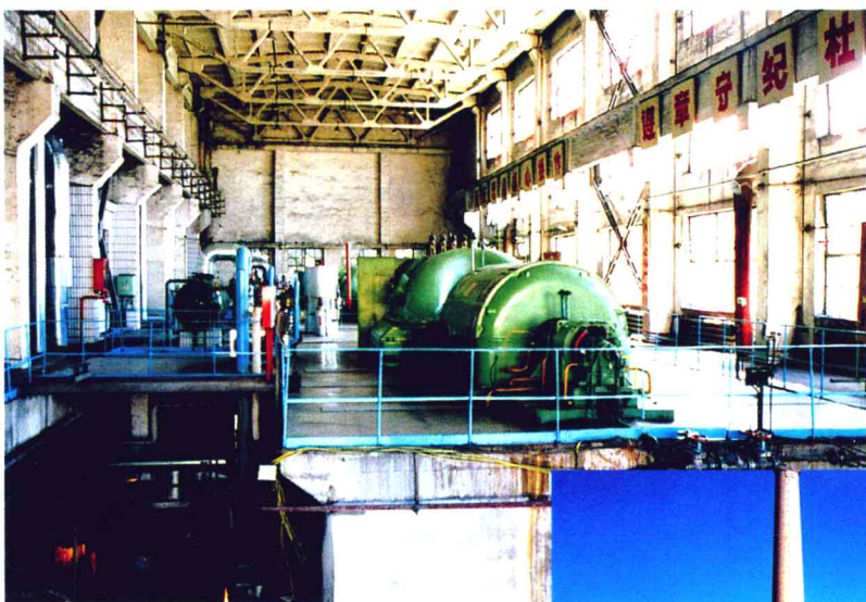
拜城发电厂气轮发电机组
