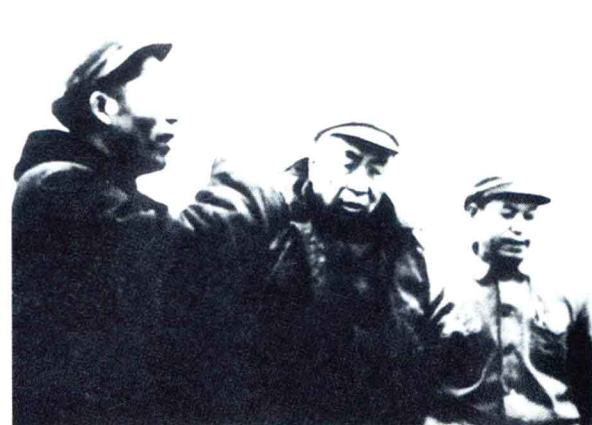
1982年12月21日国家农垦总局局长赵凡(中)在农一师西大桥水电厂施工现场听取汇报
