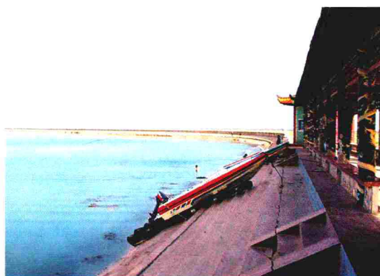
图 5-2-6 多浪水库坝体照片
