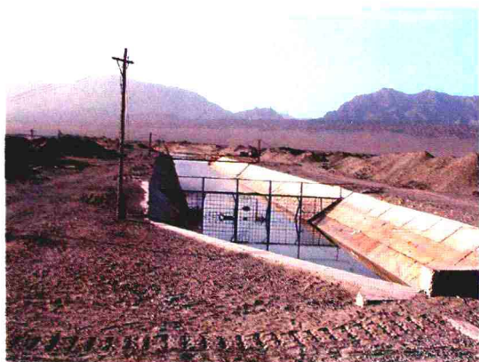
图 5-2-5 新和县干渠照片
