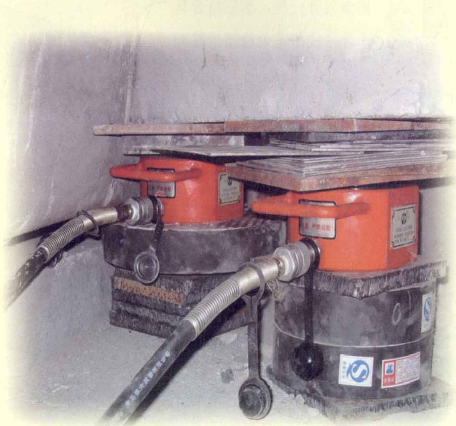
10. 千斤顶在顶升的过程中，应随着重物的上升在重物下加设保险垫层，其脱空距离应保持在50mm以内，以防千斤顶倾倒或突然回油而造成事故。到达顶升高度后应及时将重物垫牢。
