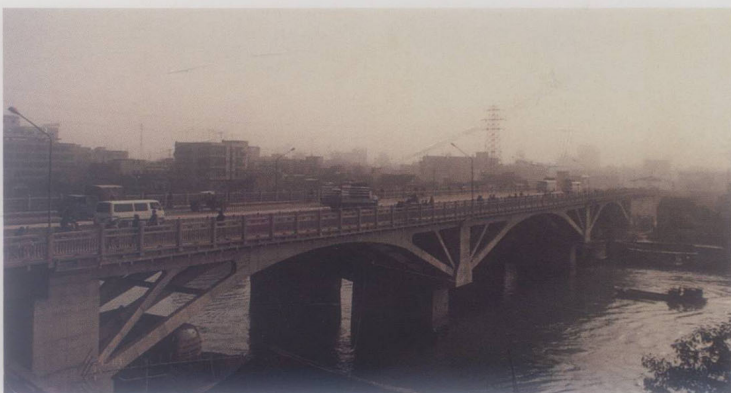
东江南支流上的东莞大桥。
