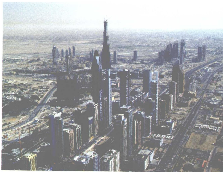
扎伊德路及建设中的世界第一高楼
