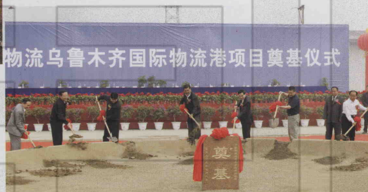
2009年7月2日，中国物流乌鲁木齐国际物流港项目在经济技术开发区举行开工奠基仪式
