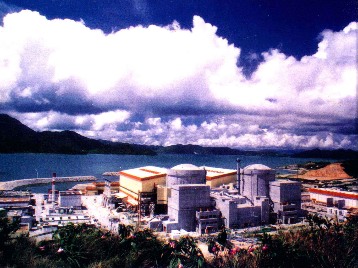
大亚湾核电站外貌
