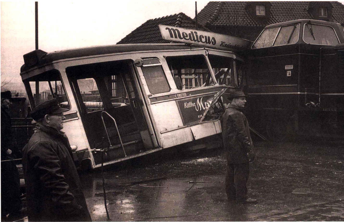
工厂铁路事故也属于铁路事故的范畴。1962 年 2 月 12 日,在杜伊斯堡的铁路道口处,一台厂用机车与一列有轨电车相撞,事故的原因是道口栏木的机械装置出现故障。事故造成 1 人死亡,32 人受伤。 图片收藏:U·保利茨
