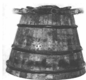
图 1-7 自流井构造早期采气井口装置——“康盆”
