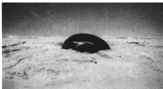
图 1.4 覆盖层土工膜隆起(Thiel et al., 2005)
