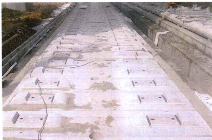
图 1.2-13 沪杭高铁 DK30+951.5~DK31+115.085 段路基
