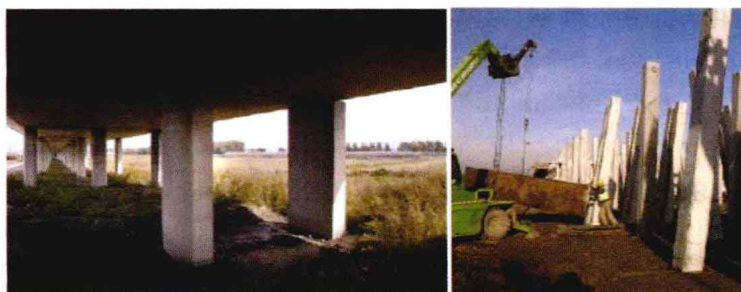
图 1.2-4 桩板结构的支承桩(HSL-Zuid)
