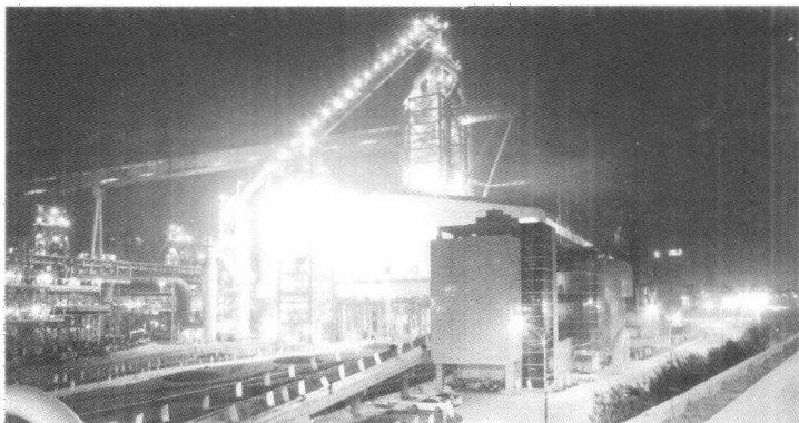
沙钢集团日产量1.4万吨的世界最大高炉——沙钢5800立方米高炉
