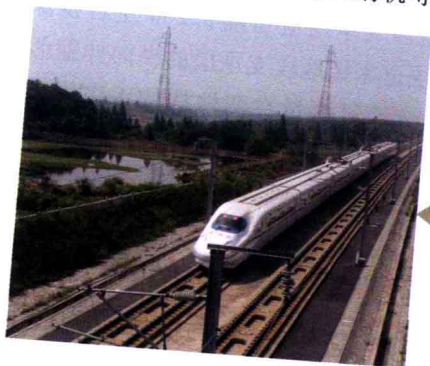
图 1—5 CRTS I 型板式无砟轨道 图 1—6 CRTS I 型板式无砟轨道结构组成
