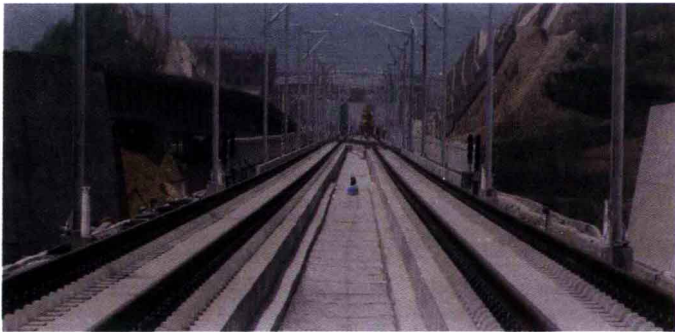
图 1—4 CRTS II 型双块式无砟轨道
