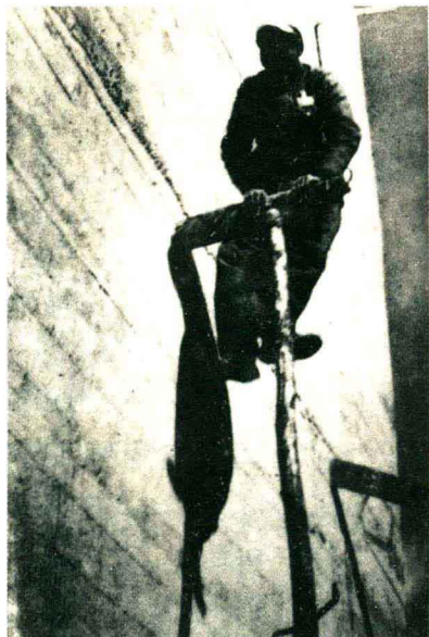
杨连第利用桥墩上残留的铁夹板搭单面脚手架强登桥墩顶
