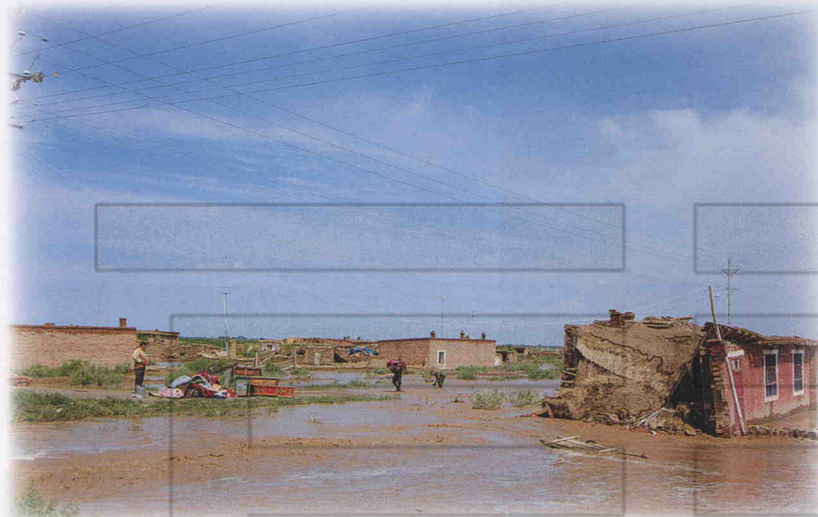
7月17日，木垒县发生60年不遇的特大洪水灾害 (县委办公室提供)
