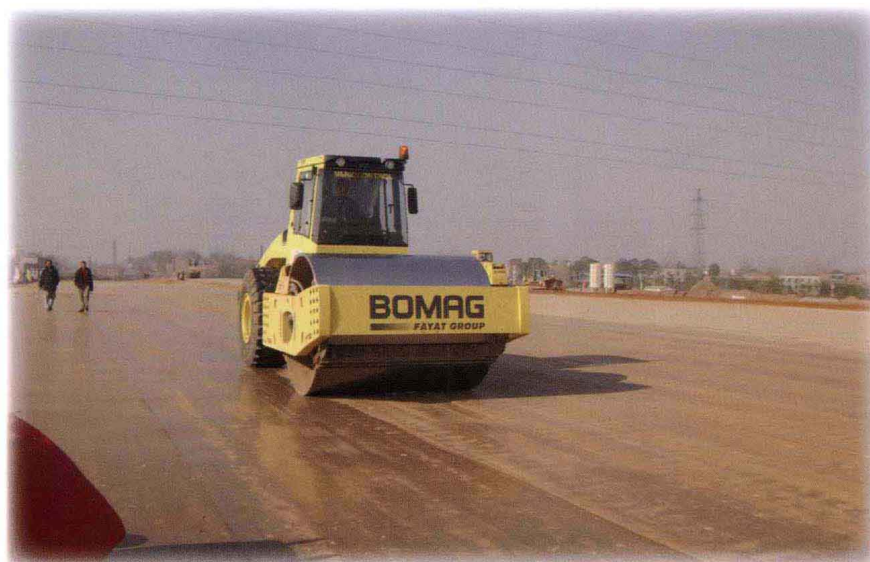
洛阳龙门站站场路基采用最先进的BW226压路机碾压
