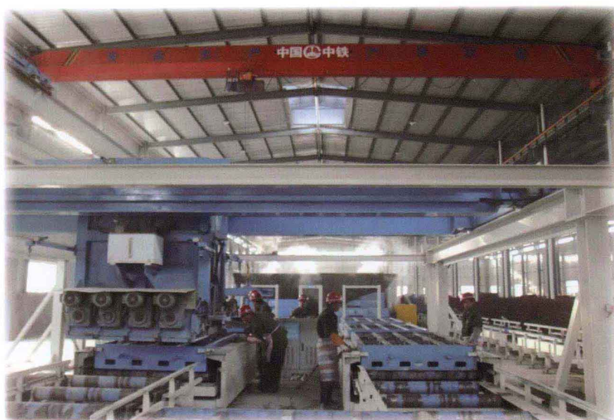
旭普林无砟轨枕生产线
