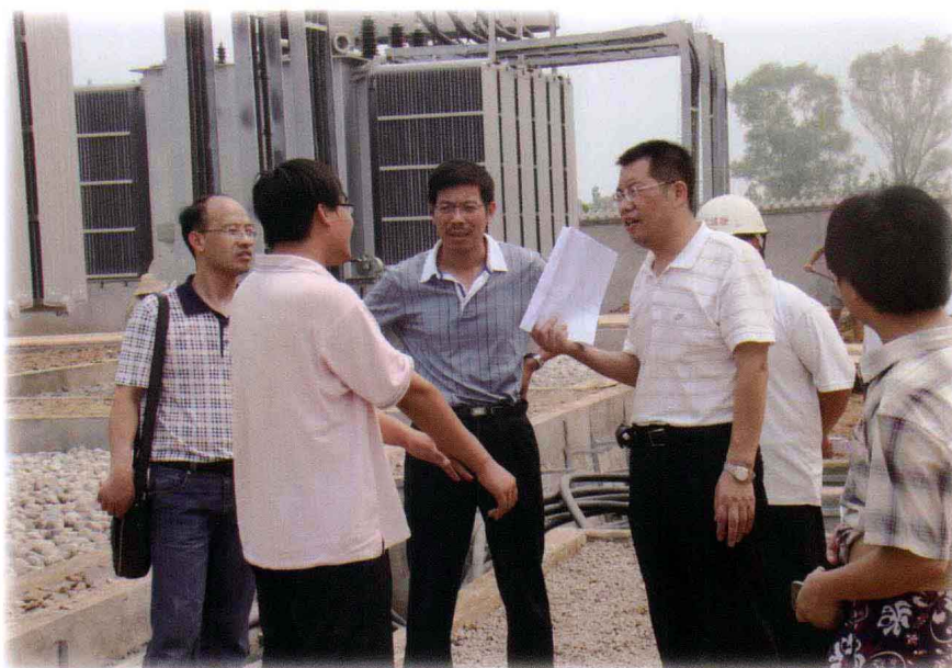
中铁建电化局指挥长(中)陪同现场检查
