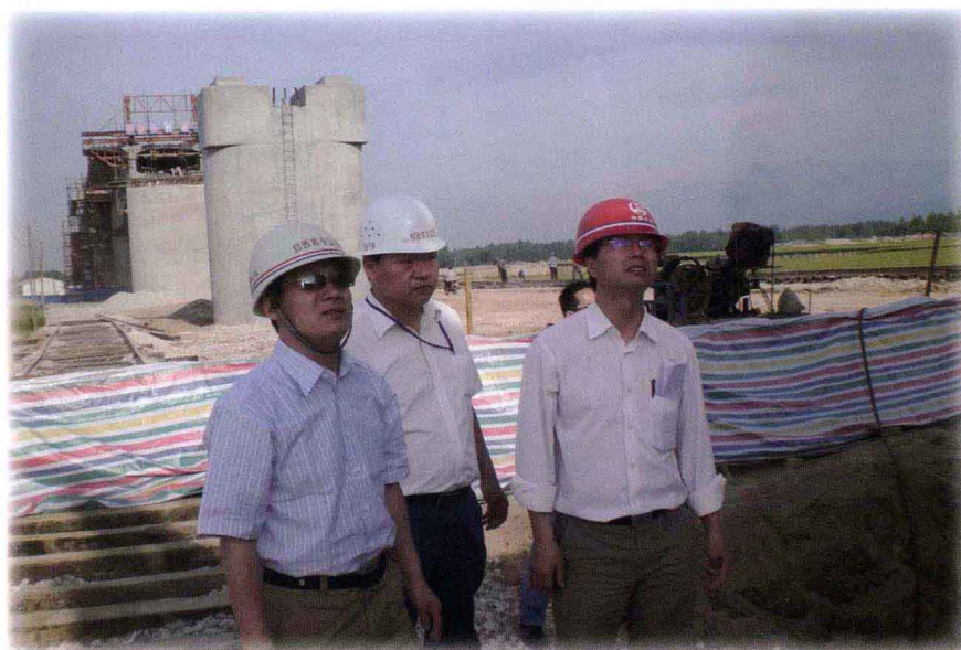
郑西第三监理站领导在渭河特大桥一跨渭河连续梁施工现场检查
