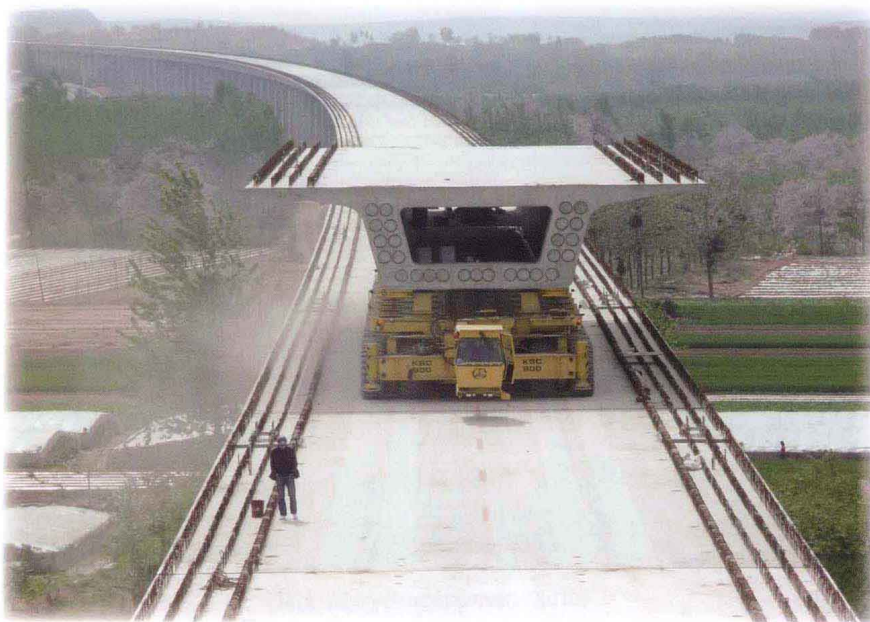
架设中的陕县特大桥
