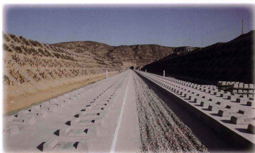
凤凰岭隧道成型的道床板
