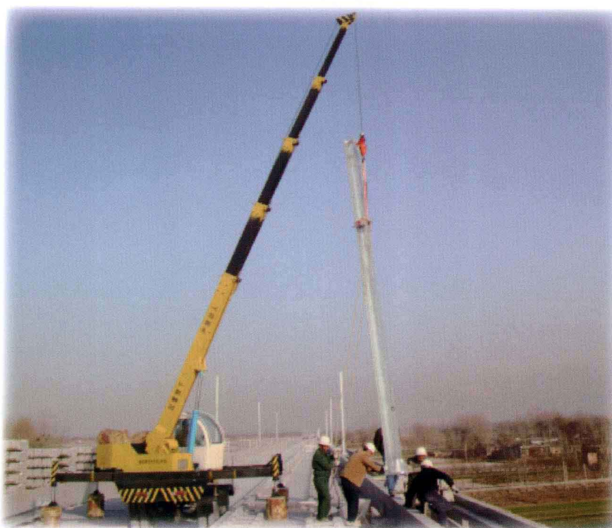
H型钢支柱安装
