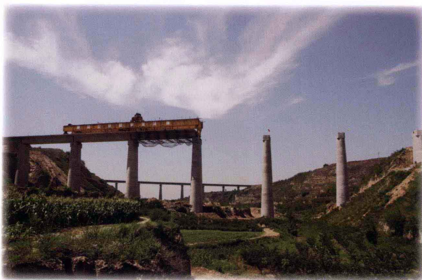
列斜沟大桥节段梁施工现场
