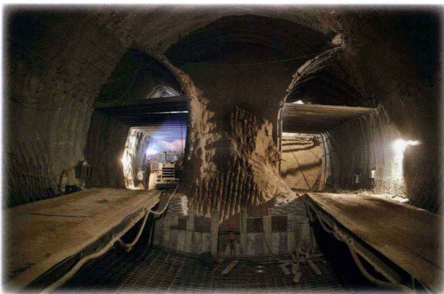
双侧壁导坑开挖法隧道施工
