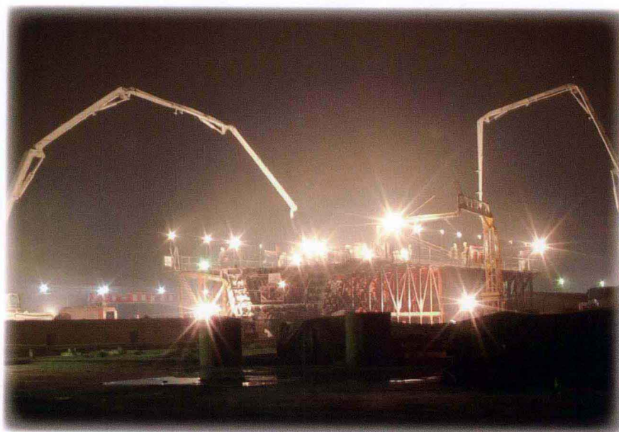
梁场夜间施工现场
