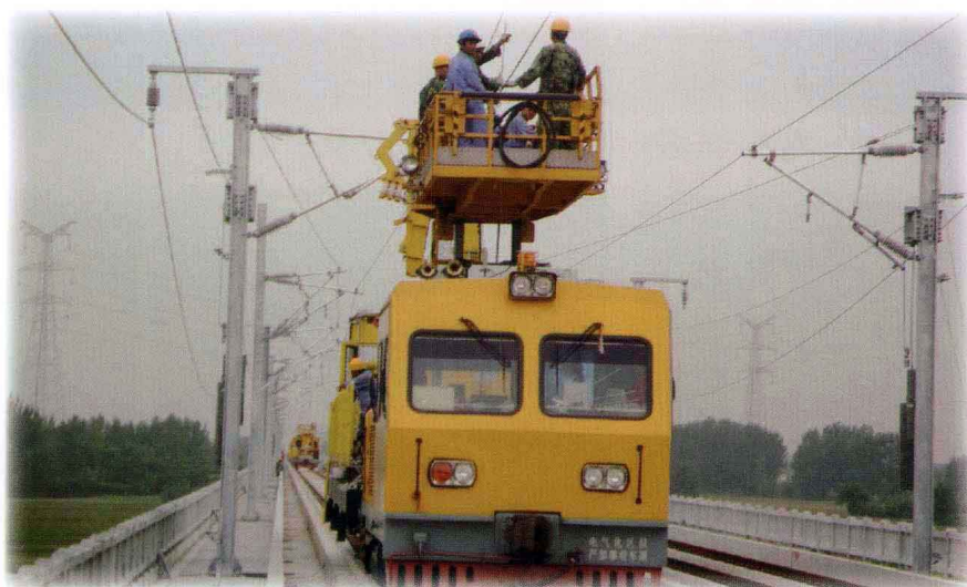
恒张力架线车架设承力索及接触线
