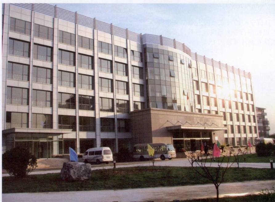
新建成的地震应急救援综合楼
