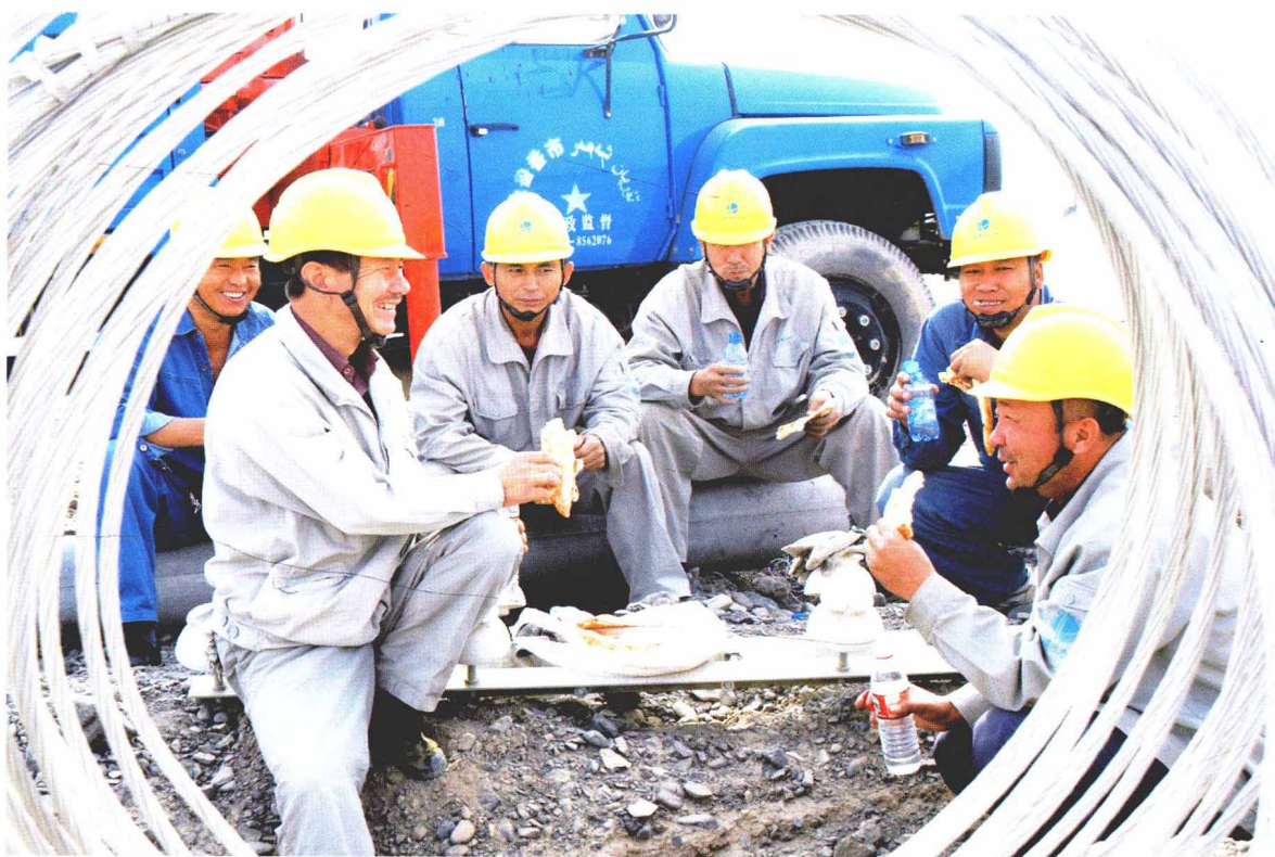
野外施工小憩
