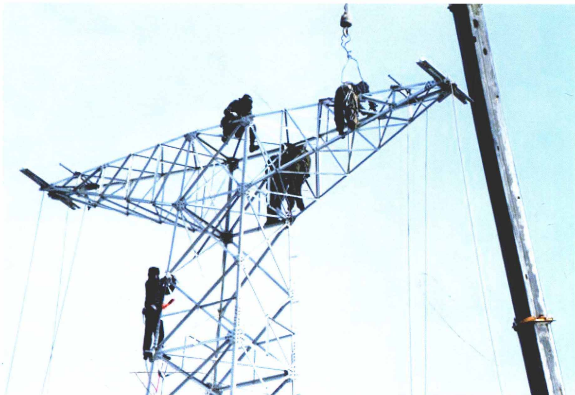
220 千伏光(哈密天光电厂)楼(楼兰变电站)线施工现场
