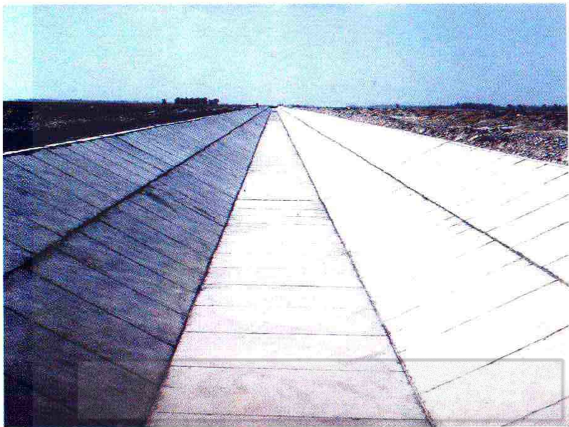
新修的铁热木干渠
