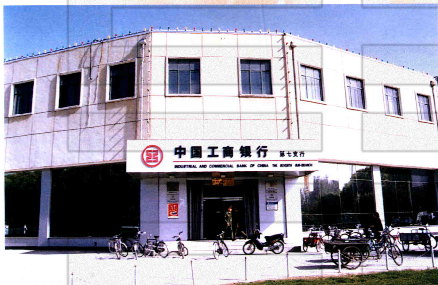
银行办公大楼
