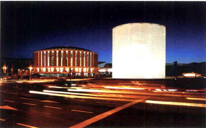
硼硅玻璃（商业上称做派热克斯玻璃（Pyrex））是一种优质浮法玻璃。它的特性包括耐高温、耐化学腐蚀、高透明度及非常高的表面质量。这些特性使其适合多种应用。在西班牙马德里的11M恐怖袭击纪念碑，就是由肖特集团（Schott Group）生产的硼硅玻璃块建造的。
