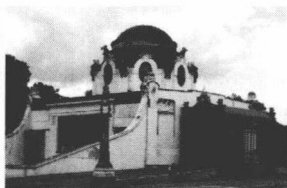
Hofpavillon轻轨站（1894–1898年）
