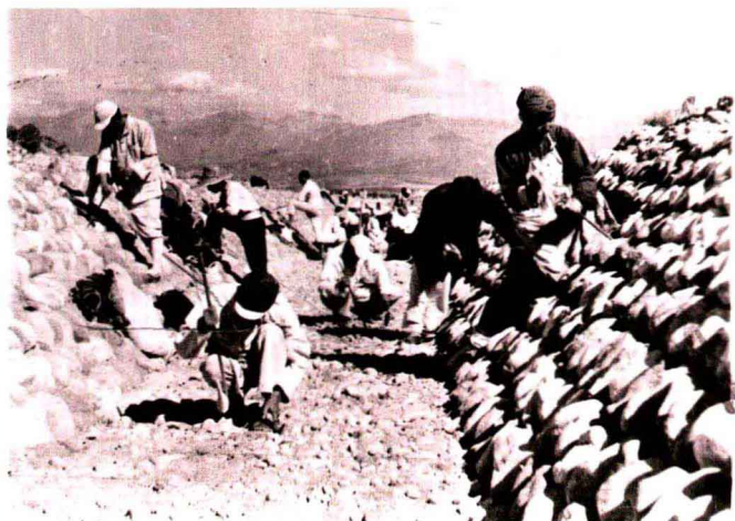
农民正在用沙子填塞水渠缝隙，加固水渠。
