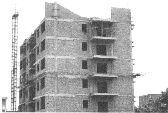
图 1-3 砌体结构（施工中）举例
