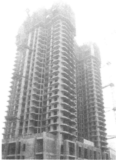
图 1-2 钢筋混凝土结构（施工中）举例
